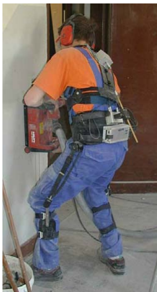
Abbildung 10: Kraft-/Druckeinwirkung bei der Bedienung einer Mauernutfräse
