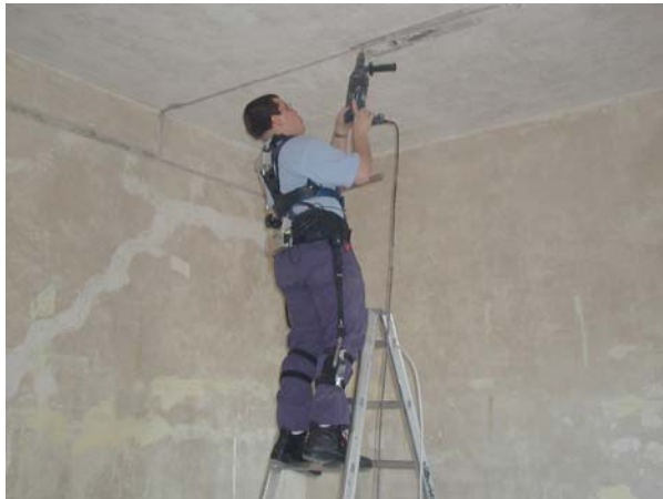
Abbildung 4: „Stehen auf der Leiter“ – Elektriker bei Schlitz- und Stemmarbeiten
