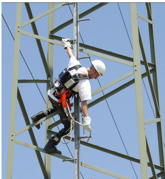
Abbildung 8: Besteigen eines Freileitungsmastes
